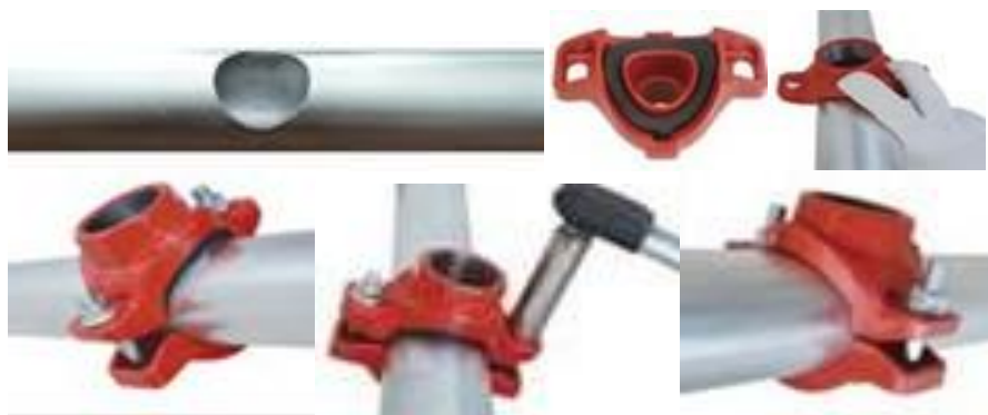
Рис.3. Установка отвода (седелка) под резьбу на трубопровод.
